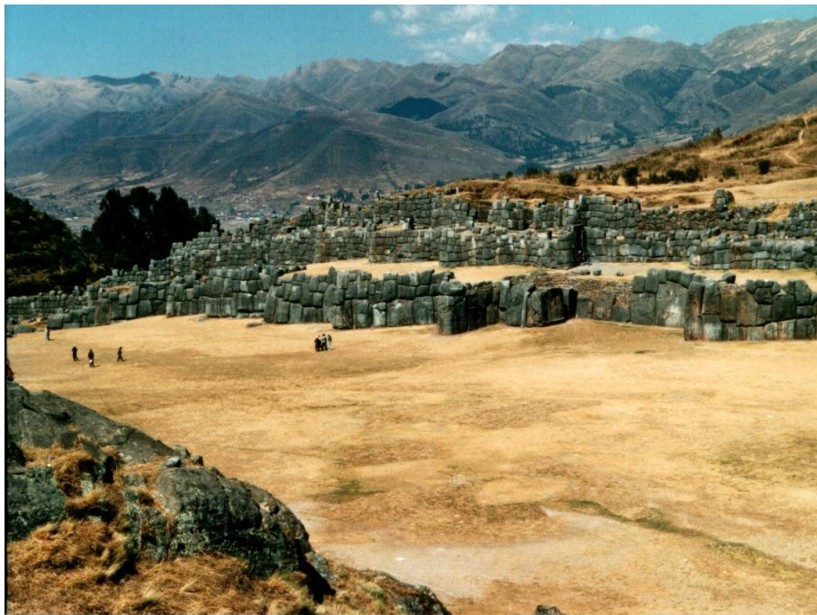
Lámina 43.- SACSAHUAMAN.- La construcción mas ciclópea de la ingeniería milenaria y lograda con piedras gigantescas tratadas y ensambladas con exactitud sin dejar resquicio entre sí. En su parte superior tiene grandes círculos de piedra en forma de líneas direccionales de eclíptica zodiacal (ver Lámina 41). Época proto- histórica.- Cordillera de los Andes, Cuzco, Perú.
